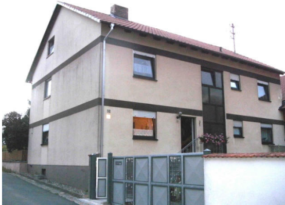
Zweifamilienhaus in Großbardorf (BJ 1977)
