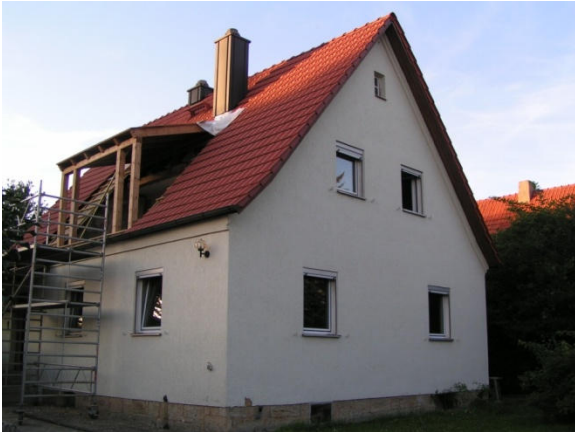
Einfamilienhaus in Bad Neustadt (BJ 1940)
