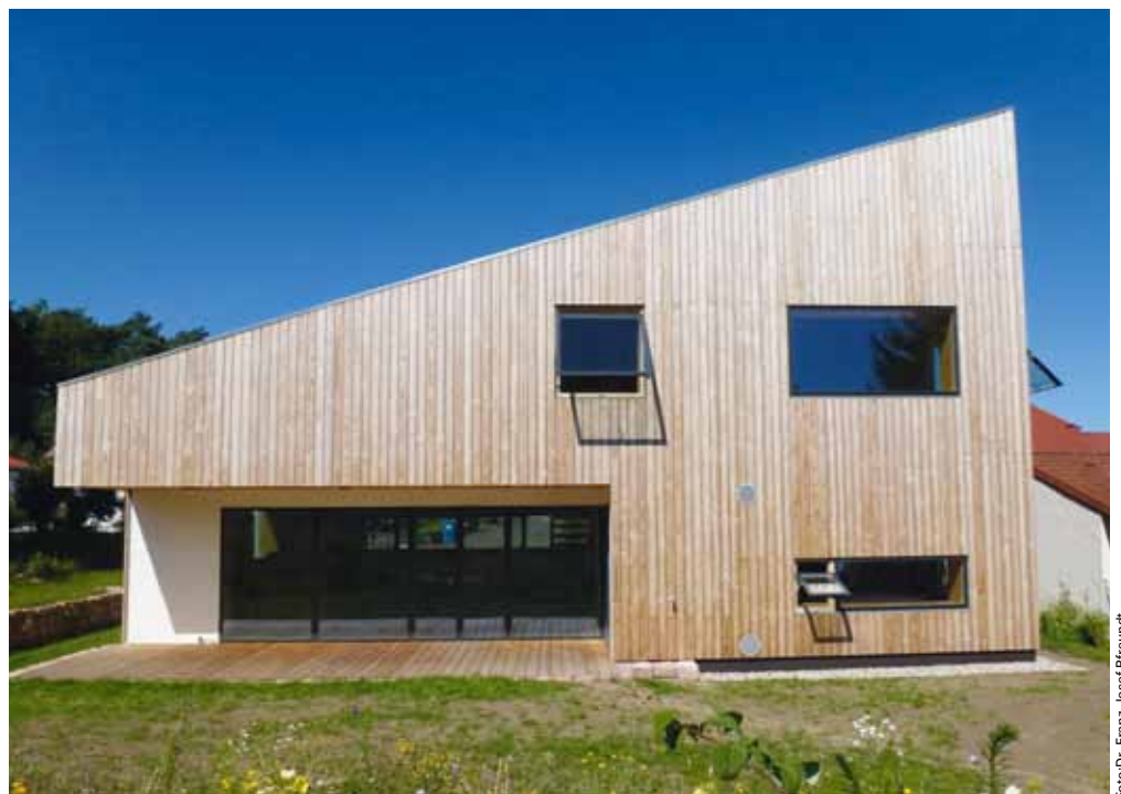
Effizienzhaus Plus in Stelzenberg
